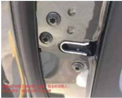
18.电吸锁安装调试
